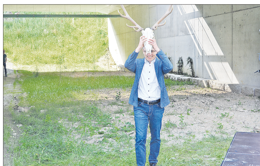
Kantonsingenieur Dominik Studer eröffnet die neue Wildtierunterführung mit einem Hirschgeweih.
